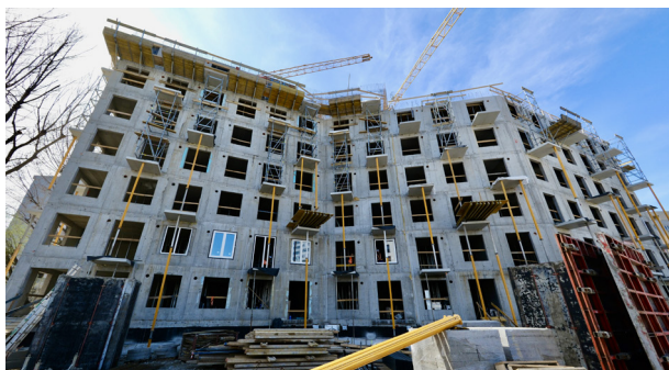
Začiatok výstavby polyfunkčného súboru Muchovo námestie, ktorý prinesie 103 nových nájomných bytov. Predpokladaný termín ukončenia výstavby 2025.
